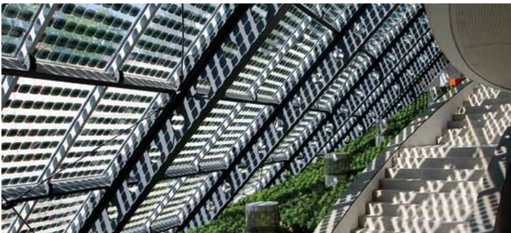
Zonnecel met aluminium spiegel
